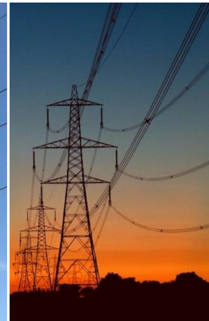
Muito alta tensão
